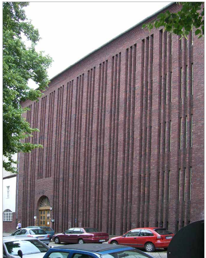
Fassade des Umspannwerks Richardstraße 20
