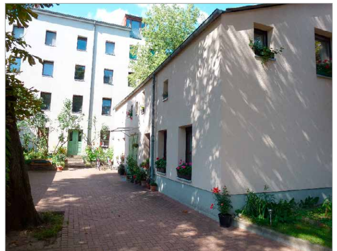
Richardstraße 22, Hofsituation, Quergebäude, Seitenflügel rechts
